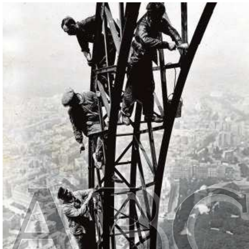
Obreros durante la construcción de la Torre
