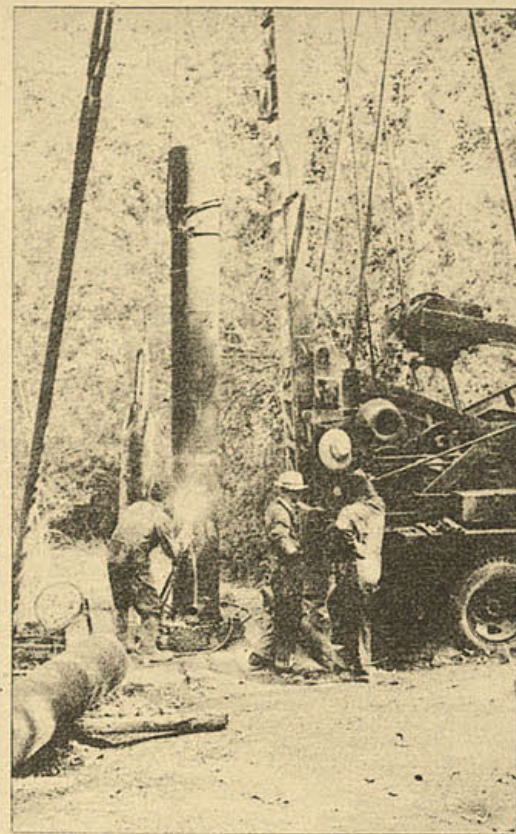
Trabajos de perforación en el pozo de «Can Sogas»
