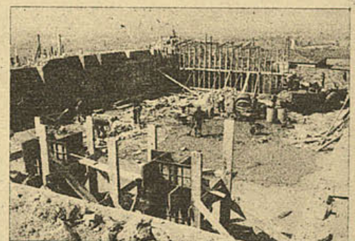
Obras de construcción del tercer depósito regulador en la montaña de «Sant Pau»
