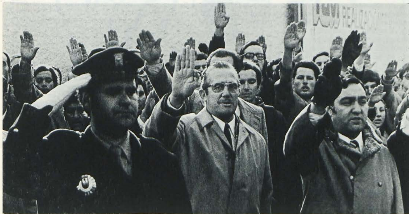
Autorizados para gritar: „Ni amnistía ni perdón; ETA y Fraga al paredón.“ Fueron escoltados por la policía del Ministro tan duramente sentenciado.
