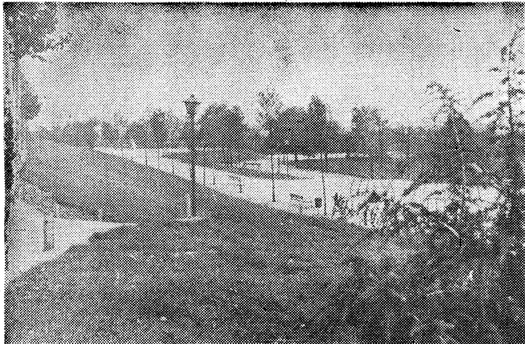
El parque del Gran San Blas, una obra al servicio de los vecinos
