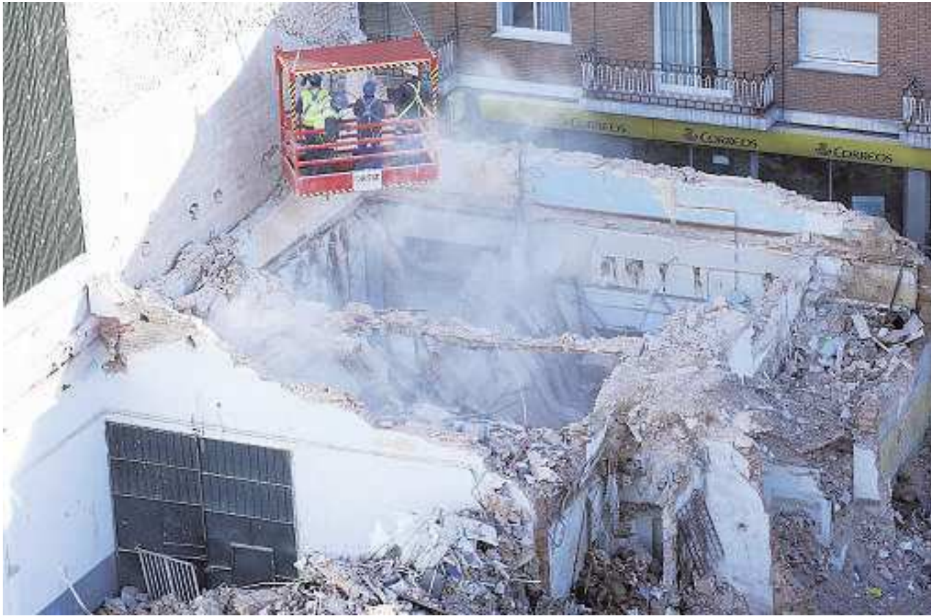
Los trabajos de demolición del inmueble afectado en la calle de Mariano Fernández concluyeron ayer
